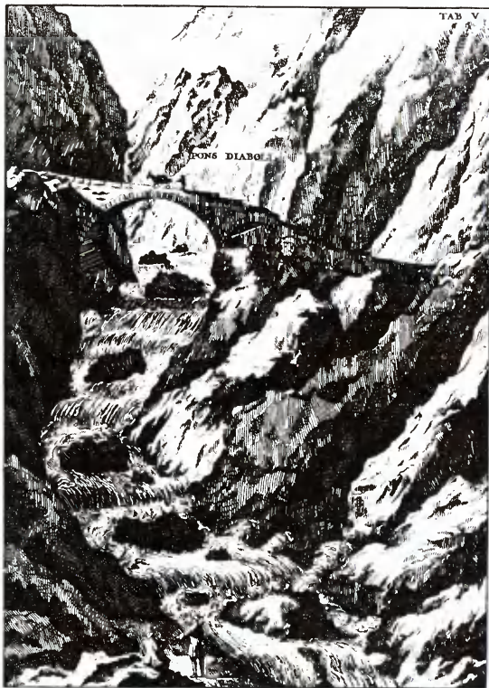
Чертов мост на пути к Сен-Готардскому перевалу в Альпах. Гравюра XVIII в. С тех пор, как он был построен в XIII в., горы здесь поднялись примерно на 1 м.
